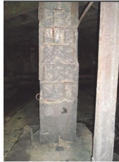
Рис. 4. Найбільш характерні пошкодження залізобетонний стійок
