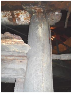
Рис. 3. Найбільш характерні пошкодження трубобетонних стійок
