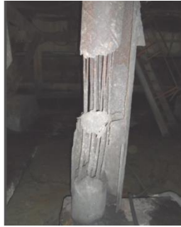
Рис. 3. Найбільш характерні пошкодження трубобетонних стійок
