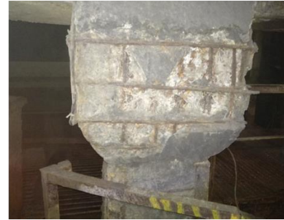
Рис. 4. Найбільш характерні пошкодження залізобетонний стійок
