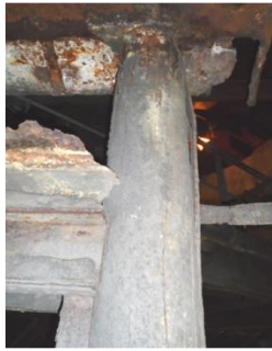
Рис. 3. Найбільш характерні пошкодження трубобетонних стійок
